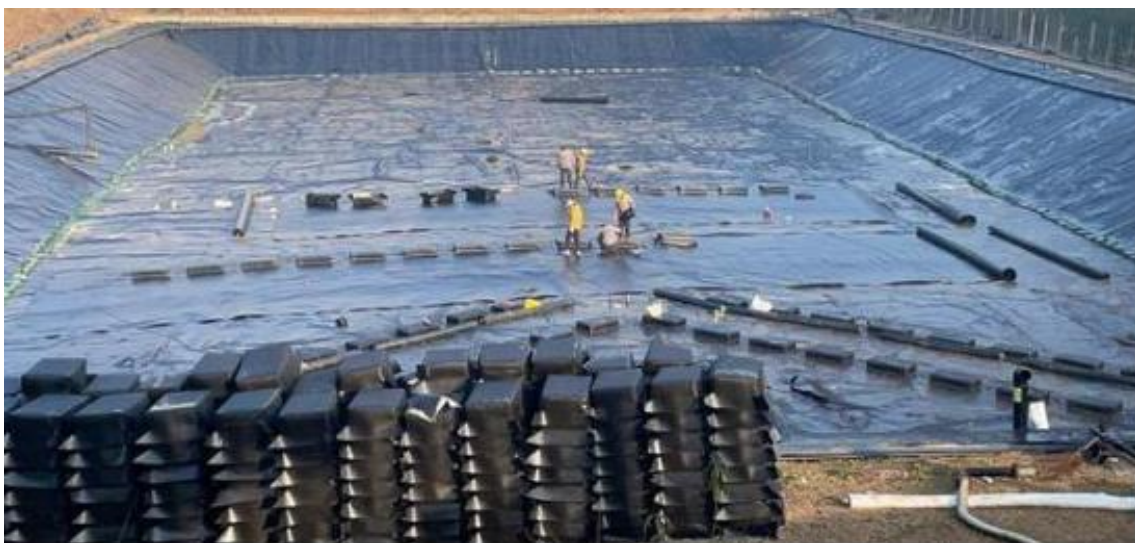
调节池池顶浮盖系统施工示意图
